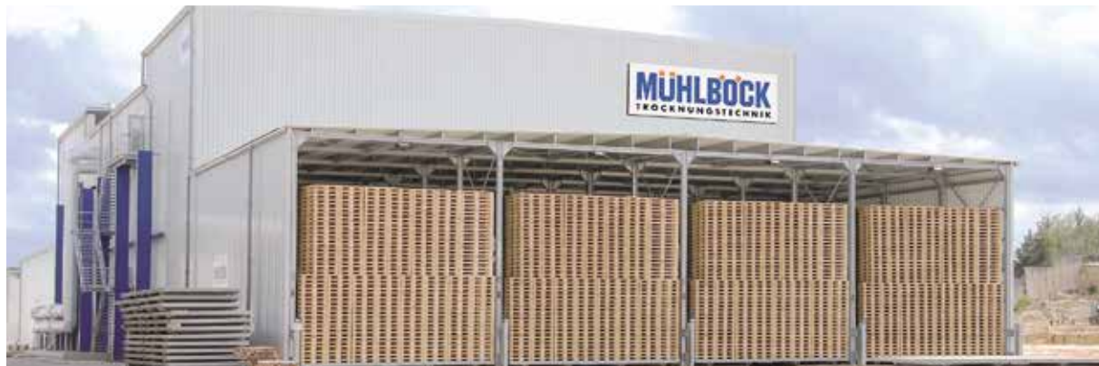
Firma Hit to największy producent europalet w Niemczech. Suszarnie tunelowe Mühlböck Typ 1003, zainstalowane w zakładzie w Torgau, pozwoliły zaoszczędzić firmie 50 procent energii cieplnej. Fot. Mühlböck
