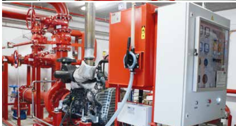
Urządzenia przeciwpożarowe instalacji tryskaczowej i zraszaczowej nowego zakładu STEICO zasilane są z pompowni, która jest wyposażona w dwie pompy przeciwpożarowe o wydatku 10 000 l/min i ciśnieniu nominalnym 8,5 bara. Pompy te zaopatrują nie tylko instalację tryskaczową w hali, gdzie produkowana jest płyta LVL, ale także hydranty zewnętrzne oraz wewnętrzne.
