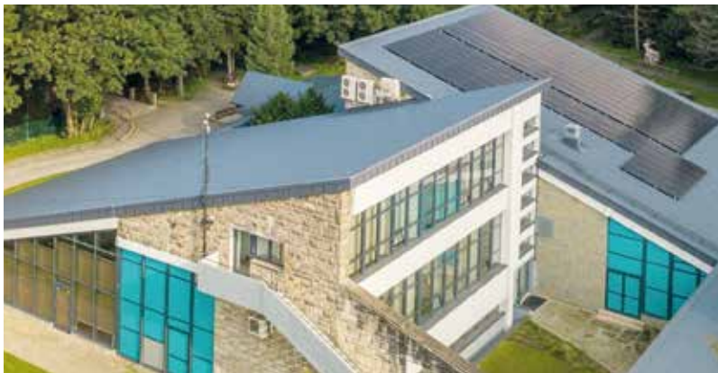
Instalacja fotowoltaiczna od IKEA, zamontowana na dachu budynku TPN, umożliwi produkcję czystej, ekologicznej energii ze słońca oraz znacznie obniży rachunki za prąd.
