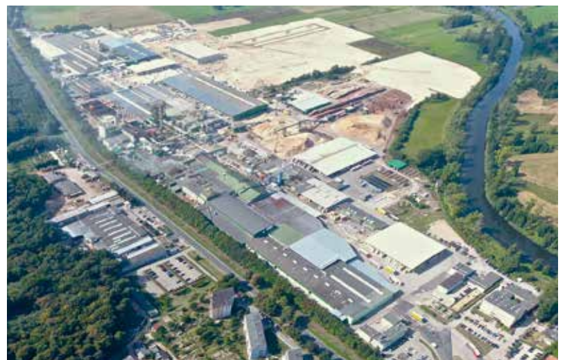
Widok na fabrykę w Czarnkowie z miejscem przygotowanym pod inwestycję, gdzie wkrótce rozpoczną się prace budowlane. Fot. STEICO
